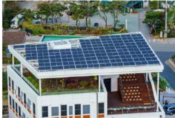
스페이스프레임을 이용한 태양광 설치
